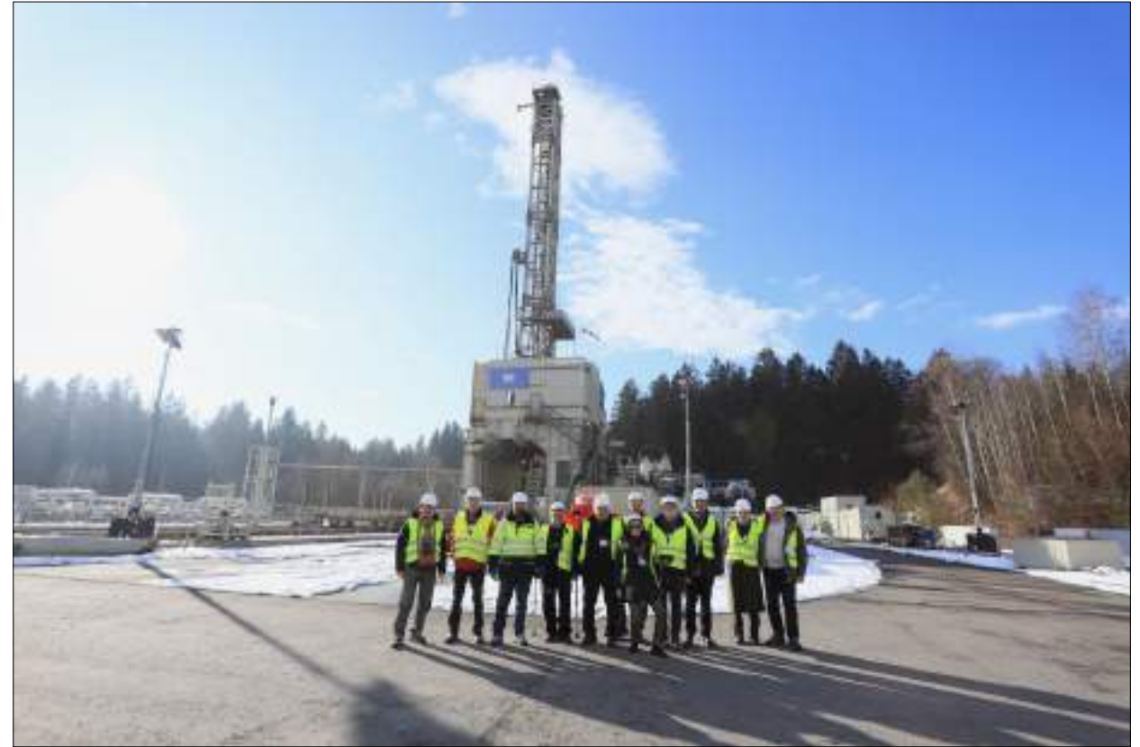
Impianto GeoTermoElettrico Tecnologia Eavor Loop, a Geresdried, in Baviera-Germania (3 febbraio 2026)
